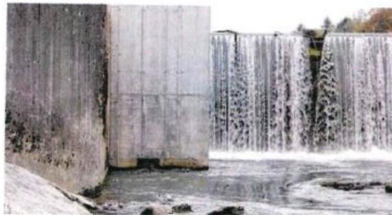
Vor dem Einstieg für die Fische unterhalb des Wehrs wurde das Flussbett der Iller so verändert, dass eine sogenannte Lockströmung die Tiere zur Aufstiegshilfe führt.
