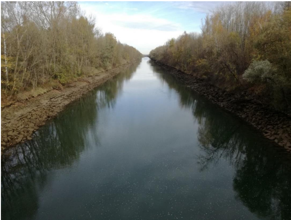
Foto: teilabgelassener, kanalartiger Querschnitt mit Uferpflasterung
